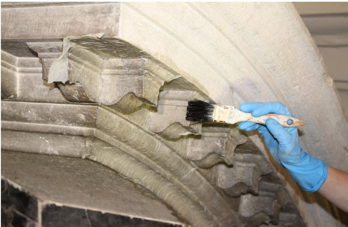
Applicazione dell'ovatta di cellulosa a supporto della soluzione acquosa di carbonato d'ammonio.
