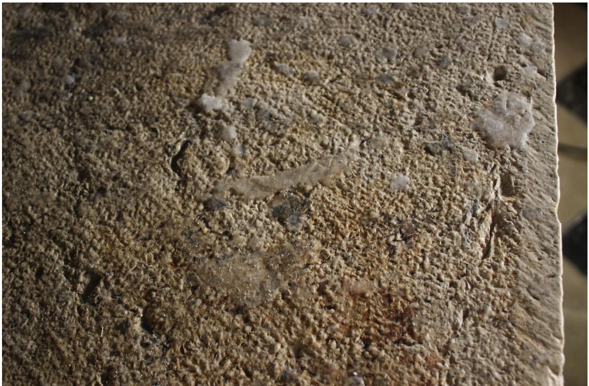
La pietra era macchiata di materiali di natura diversa, la prima foto mostra una resina ingiallita sul fiore del capitello, la seconda una serie di gocciolature di cera sulla mensa.
