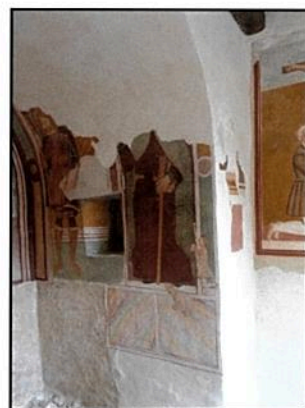
Particolare del paramento a destra dopo il restauro.
