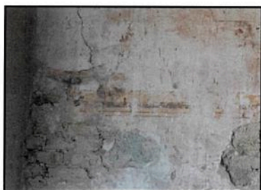
Particolare della parete sinistra durante la rimozione delle malte cementizie prima del restauro.
