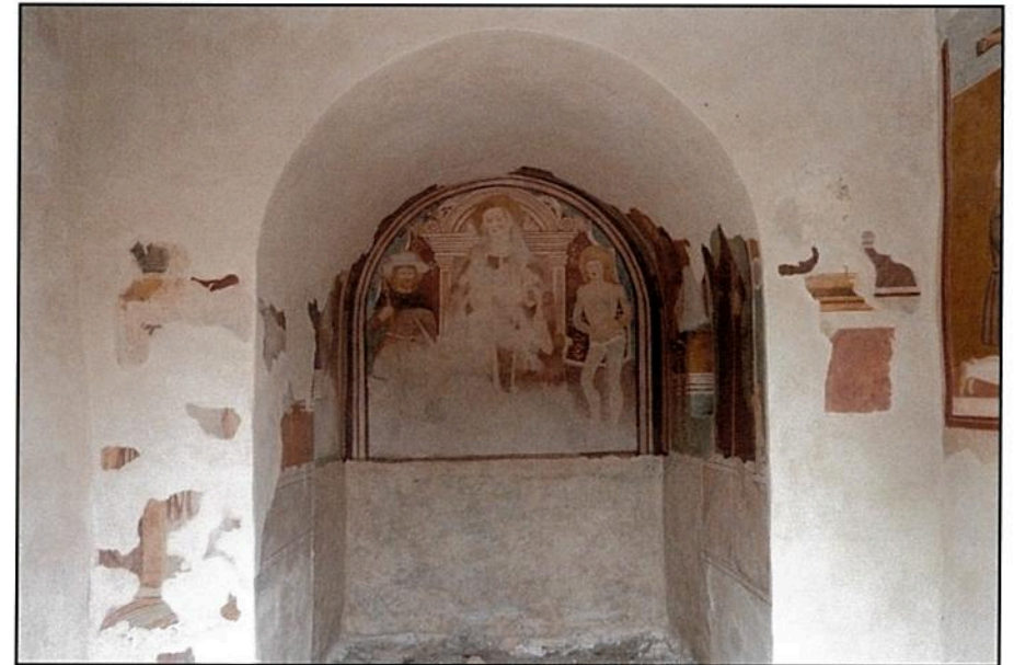
Veduta d'insieme dell'interno con gli affreschi bellunelliani dopo il restauro.
