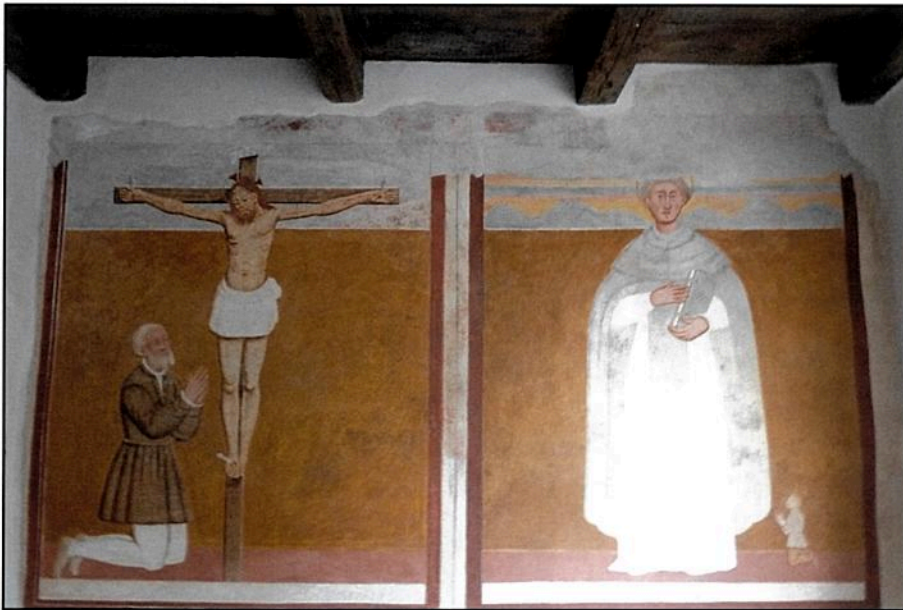
Vista d'insieme della parete destra dopo il restauro.
