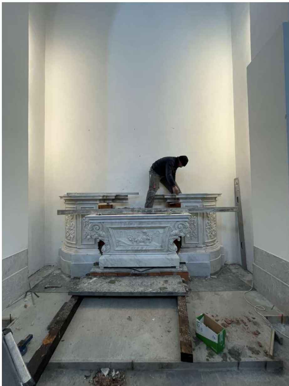
2022 01 24 Il ri assemblaggio della parte basamentale
