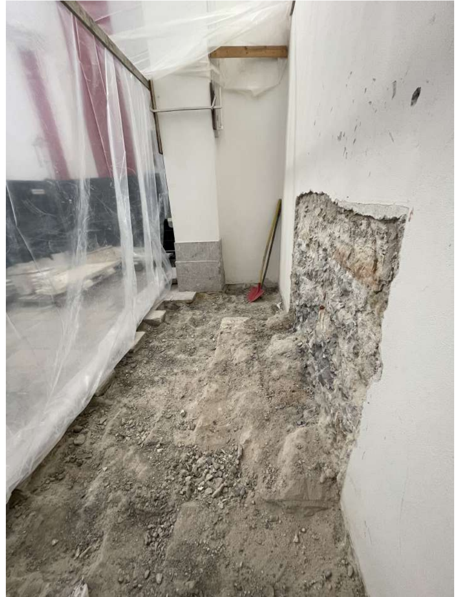
2022 01 13 La demolizione del pavimento e del basamento in conci
