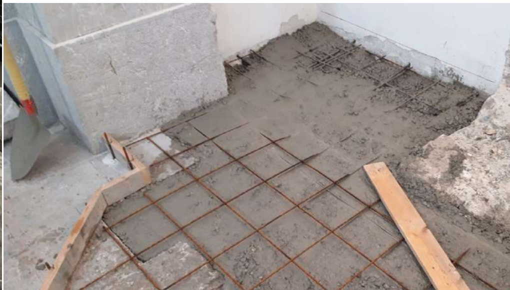
La formazione della caldana in calcestruzzo e rete elettrosaldata
