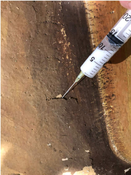
Foto del consolidamento ad iniezione ed a rullino
