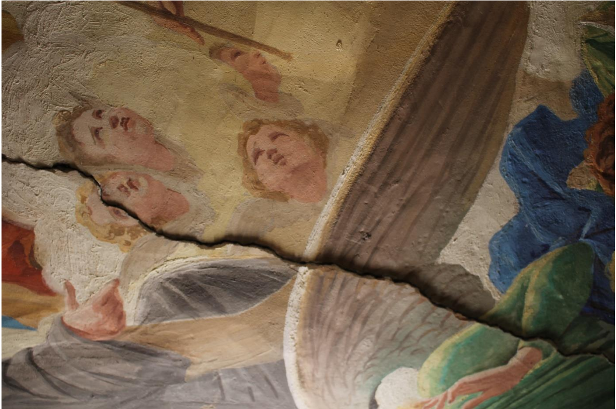
In evidenza la perdita di planarità in corrispondenza della frattura.
